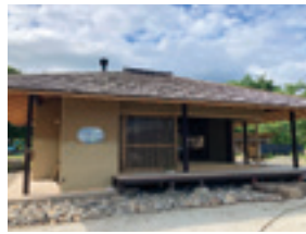
【地元産木材を使用した事務所外観】
