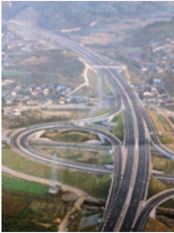
【中央自動車道】
